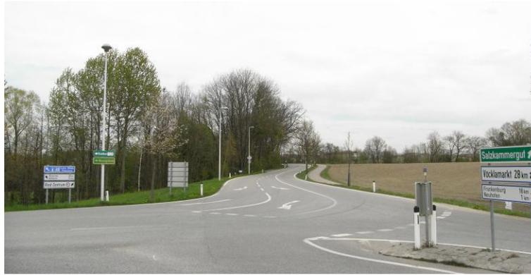
Die bestehende, verkehrstechnisch kritisch zu beurteilende Anbindung der L 509 aus Richtung Neuhofen ist auf eine Länge von etwa 110 Metern umzubauen. Sie wird im Außenbogen östlich des Bestandes der L 509a mittels T-Knoten neu angebunden.
